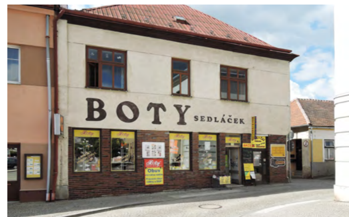
V objektu sídlí jen jeden velký ochod, ale přemírou označení, polepů a reklamy se hodnota nevýrazného domu ještě zhoršila a zakryla nonstop přístupný automat na nápoje (Jevíčko)
