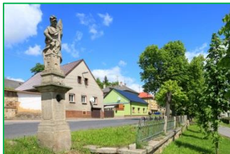
Opěrná zeď pod lípami
