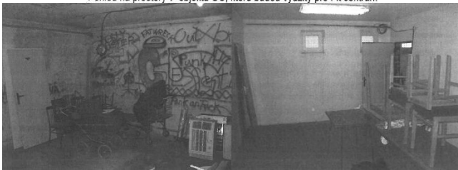
Pohled na prostory v objektu OÚ, které budou využity pro Fit centrum
