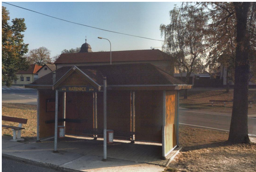
Obrázek 8 - Autobusové zastávky v obci
